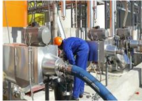
Unité de recyclage de déchets
